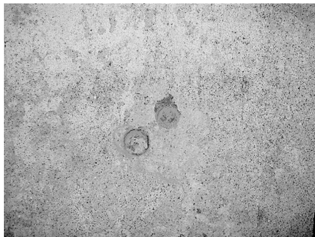
Рис.1. Отбор проб из сводчатого перекрытия
