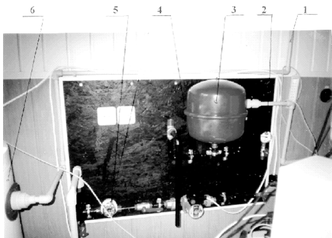
Рис.4. Панель с элементами системы автономного теплоснабжения на базе жидкостного солнечного коллектора.
