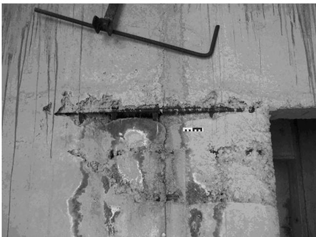
**Рис. 4 Непробетонированный участок.**
