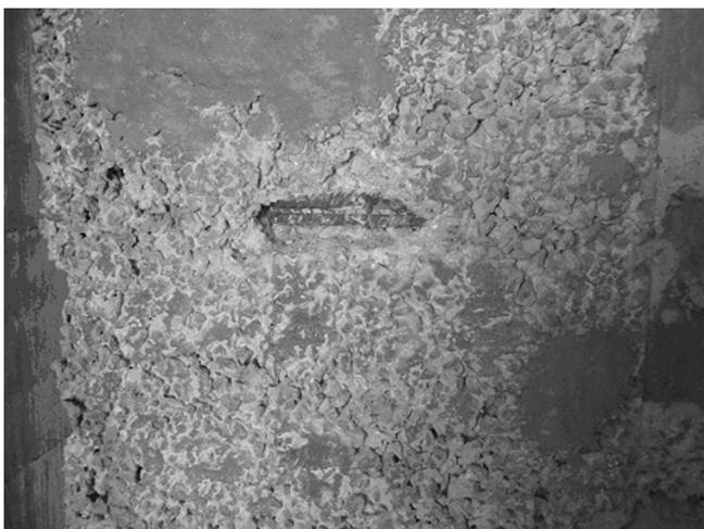
**Рис. 5 Удаление неплотного бетона для выяснения глубины его распространения.**
