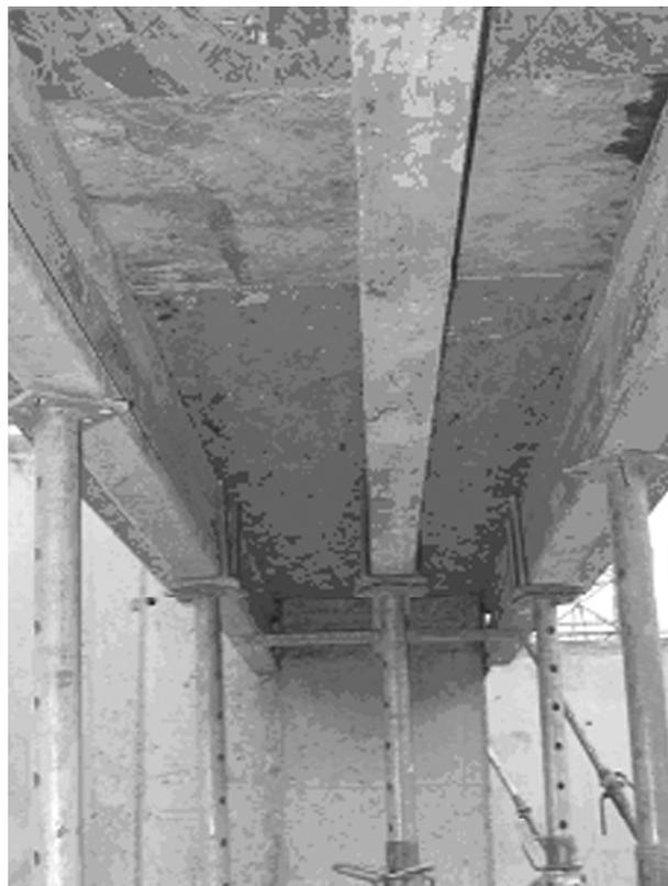
**Фото 2. Традиционная опалубка для лестничной клетки досок узкой балки.**
