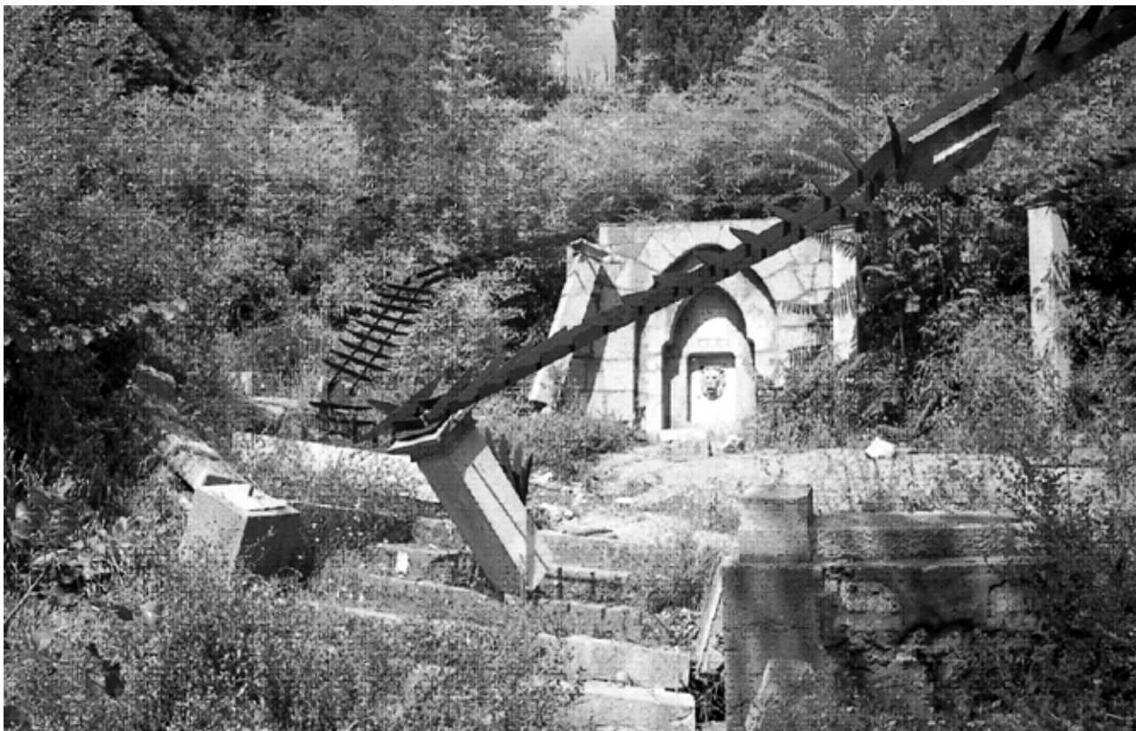
Рис. 4. Разрушение Лавровой беседки правым бортом «Западного» оползня. комплекса.
