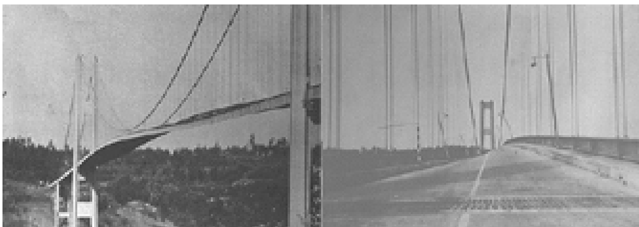
Рис. 1 и 2. Скручивающее колебание моста
