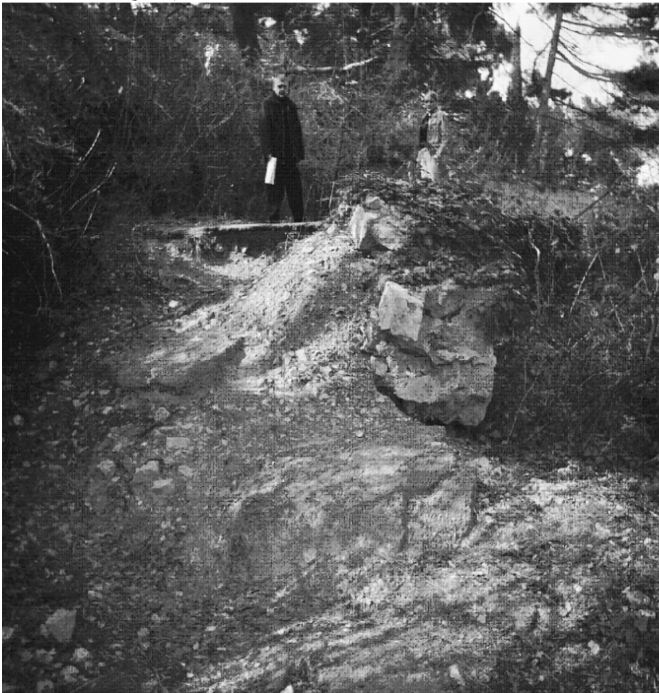
Рис. 3. Разрезание дороги с ограждающими подпорными стенами левым бортом «Западного» оползня.
