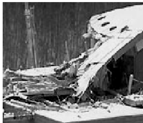
Рис.8. Обломки крыши «Трансвааль-парка»
