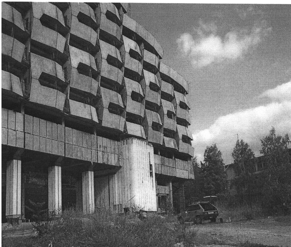
Рис.1. Общий вид смонтированных конструкций блока №1. Южный фасад
