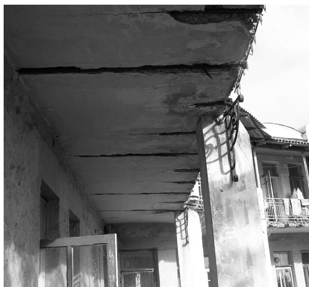
**Рис. 5. Коррозия несущих балок в балконной плите.**
