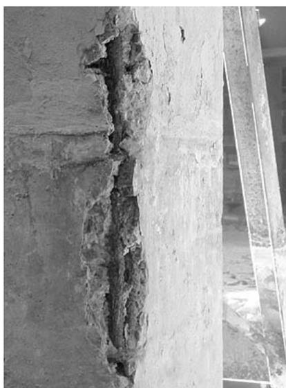
**Рис. 4. Коррозия арматуры в железобетонном столбе.**
