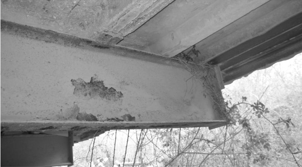
**Рис. 1. Сплошная коррозия под слоем пыли уноса.**
