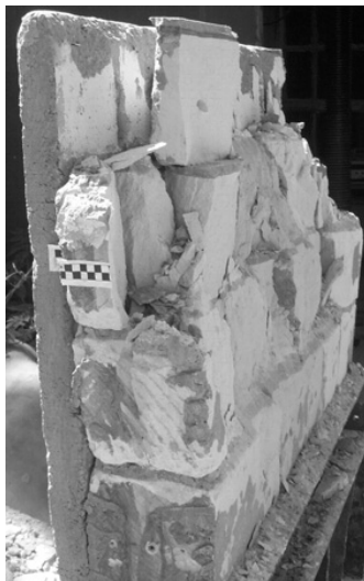
Рис.7. Разрушенный образец серии КОХ с хомутами в виде металлических шпилек
