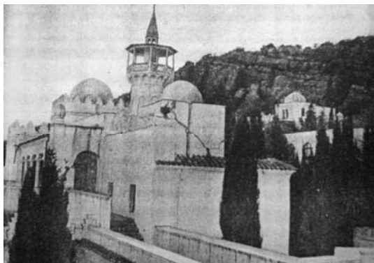
Рис. 1. Дворец «Кичкинэ» после землетрясения 12.09.1927 г.
