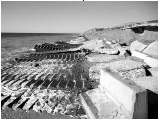
Рис. 3. Разрушения берега в п. Песчаное
