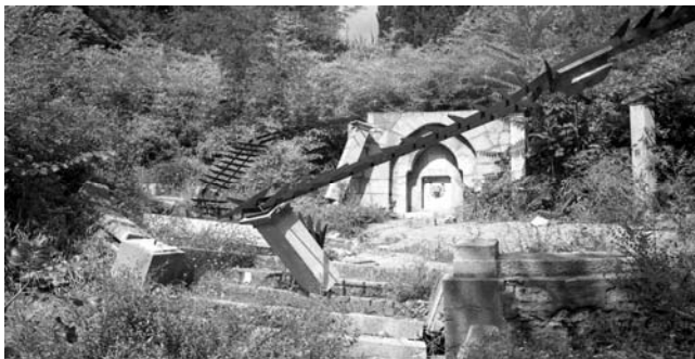
Рис. 3. Разрушенная оползнем в Ливадийском парке
