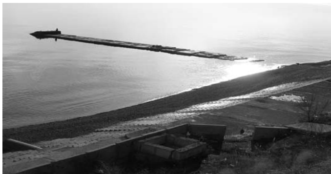
Рис. 6. Незавершённое строительство берегозащиты в районе пгт. Морское.
