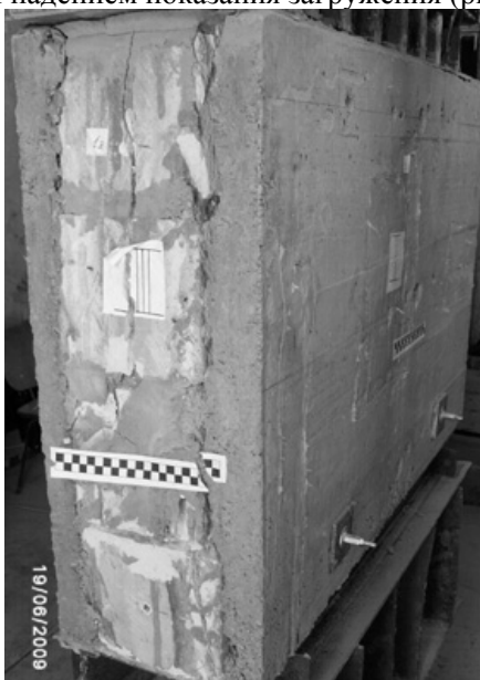
Рис.6. Трещины по двум сторонам обоймы простенка серии КОХ с хомутами в виде металлических шпилек
