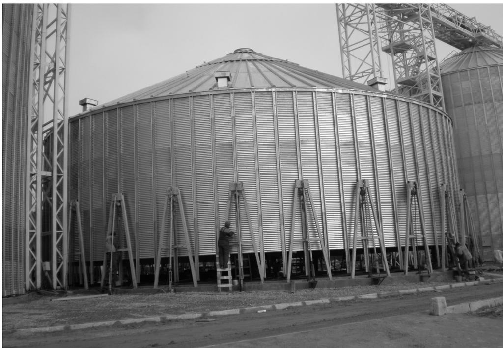
**Рис. 1. Общий вид силоса со смонтированными шестью ярусами (силос в подвешенном состоянии, монтажники крепят вертикальные ребра жесткости на болтовых соединениях)**
