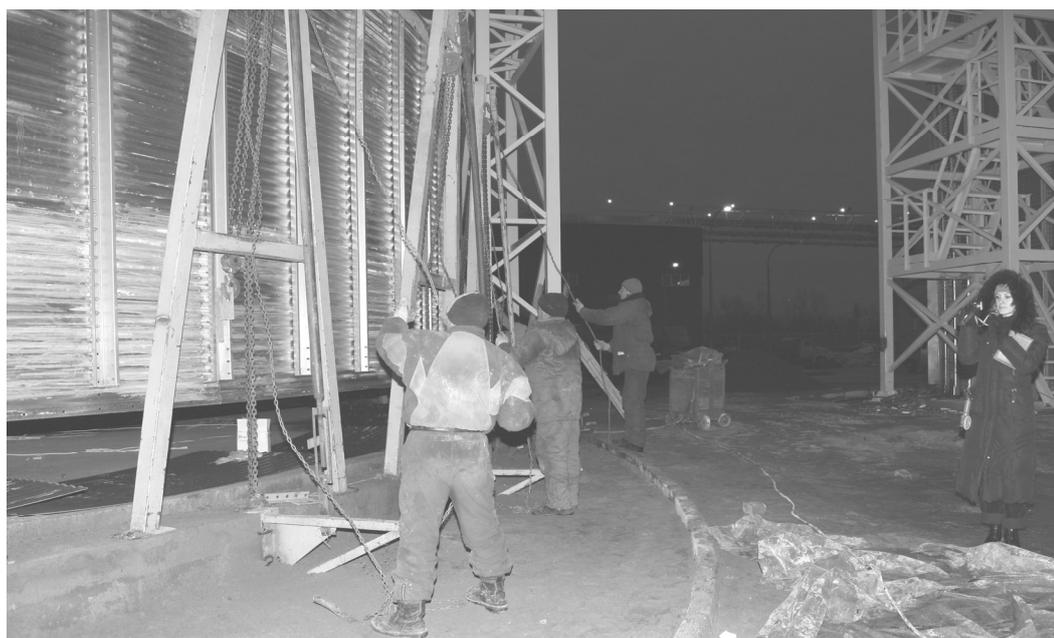
**Рис. 2. Видеосъемка процесса монтажа силоса, снятие хронометражных замеров и усилий**
