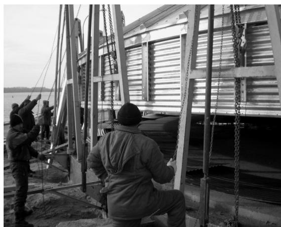
**Рис. 4. Подъем первого яруса силоса на достаточную высоту (1,14-1,2 м) для подращивания**
