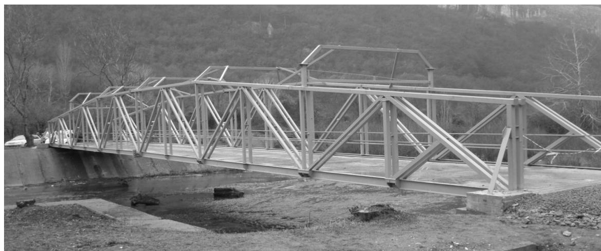
**Рис.1 Мостовой переход пролетом 36 м**
