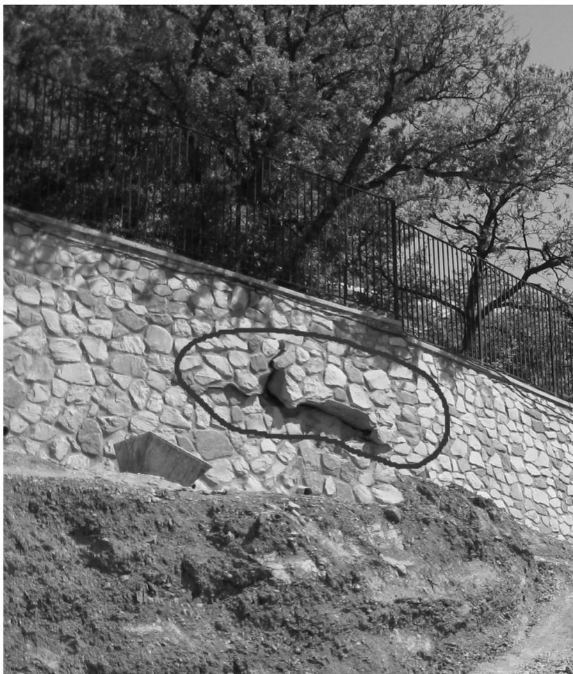
**Рисунок 1. Вывал отдельных элементов подпорной стены в пгт. Парковое, пос. Жуковка**
