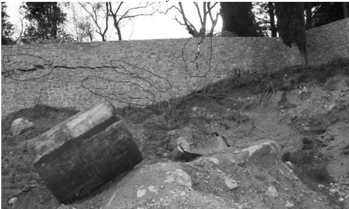
**Рис. 2. Разрушения по нормальным и наклонным сечениям, а так же вывал отдельных частей подпорной стены в г. Алушка.**
