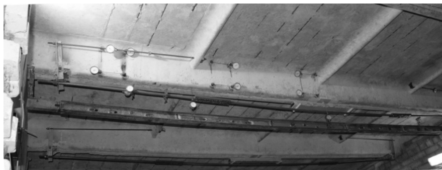
Рис.2. Загальний вигляд плити покриття під час випробування
