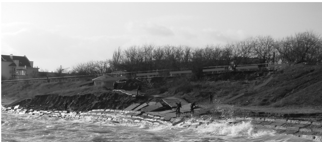
Рис.1 Общий вид оползневого участка.
