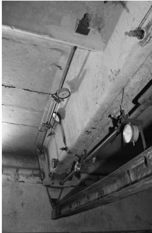
Рис.3. Розміщення індикаторів годинникового типу на бетоні та зовнішній арматурі конструкції підсилення плити покриття
