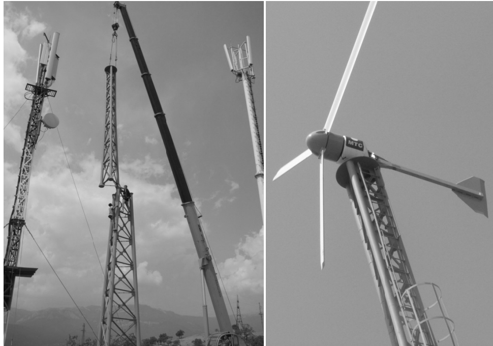
Рис. 1. Монтаж ВЭУ для электропитания БС мобильной связи в пгт. Малореченское.
