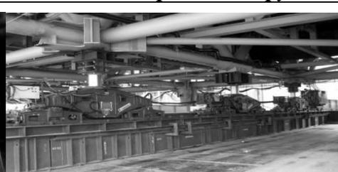
**МП<sub>16</sub>** - виштовхуванням із застосуванням гідравлічних підйомників фірми *FAGIOLI*. Поруч розміщений телескопічний домкрат фірми *FAGIOLI* **5000/18/250**
