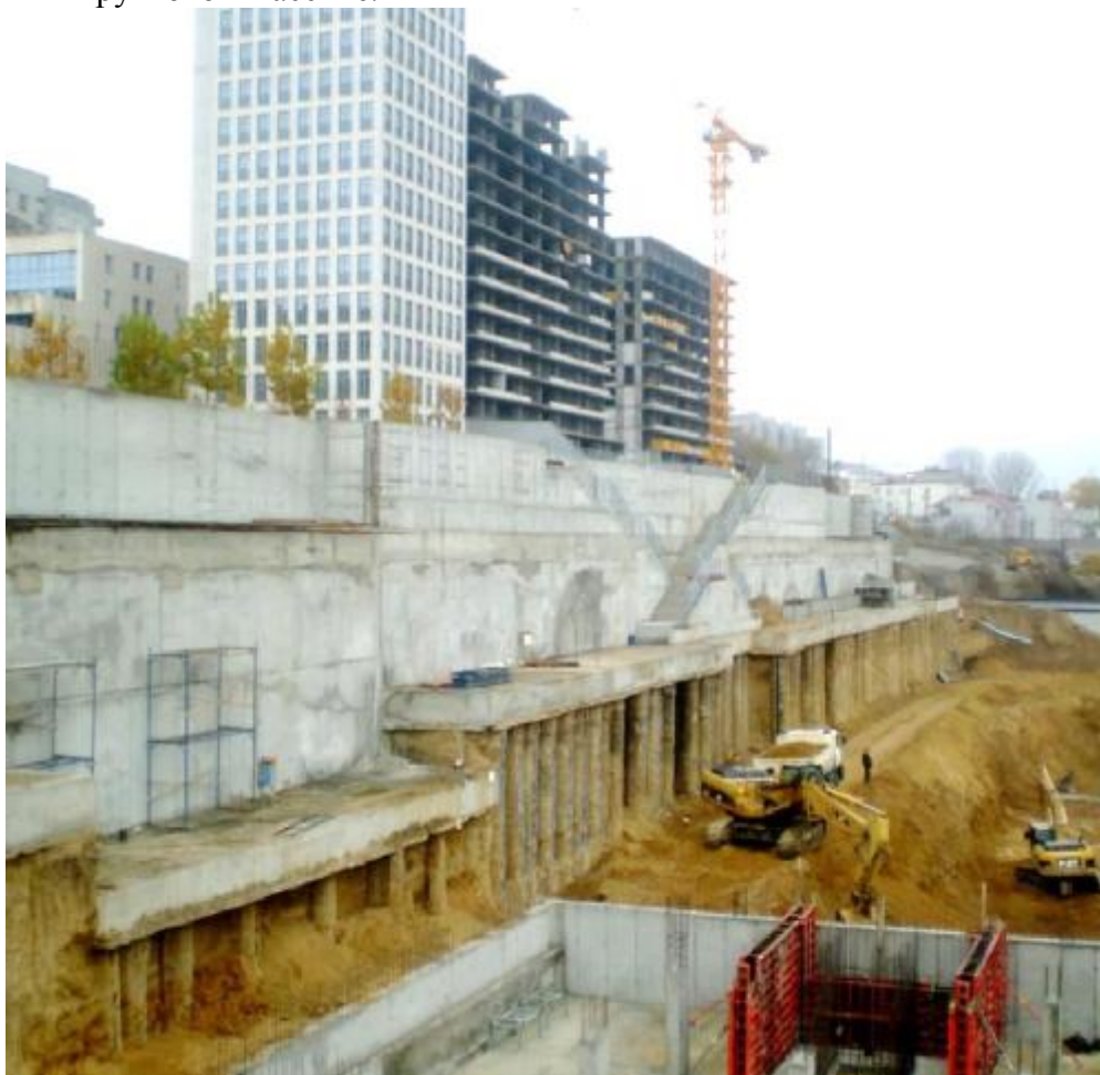
Рис.1. Разработка грунта перед свайной удерживающей конструкцией [4]
