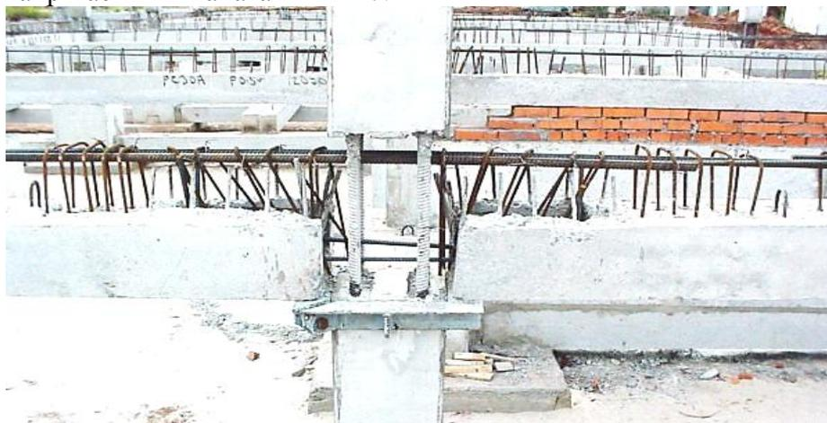
**Рис. 1. Узел сопряжения колонна-ригель**
