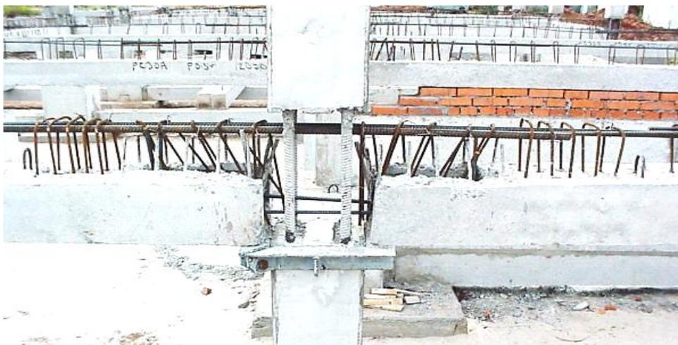
**Рис. 1. Узел сопряжения колонна-ригель**
