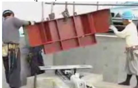
Рис. 4. Крепление угловых узлов рамы
