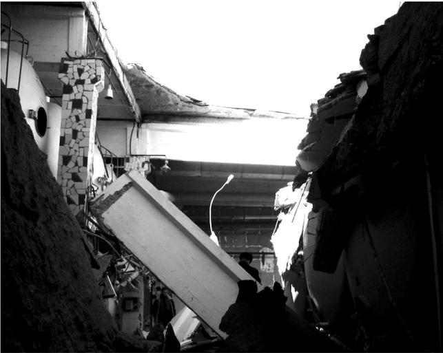
Рис.3.Часть разрушенной балки БО12-3 по оси «2»
