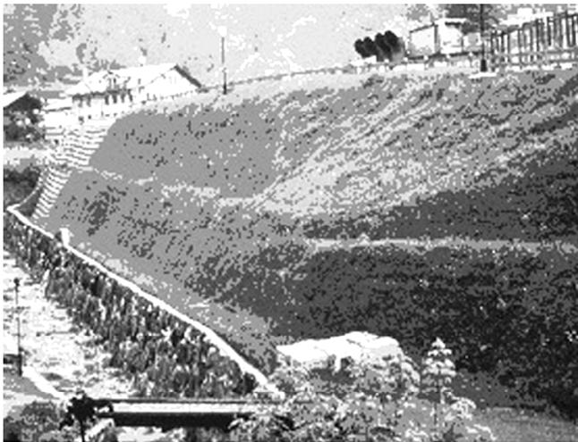
**Рис.2. Озеленение поверхности подпорной стены**
