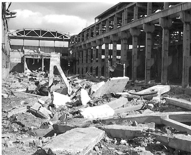
Рис.1 Обрушение пролета цеха
