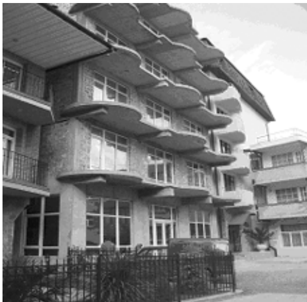
Рис. 1. Главный фасад здания.
