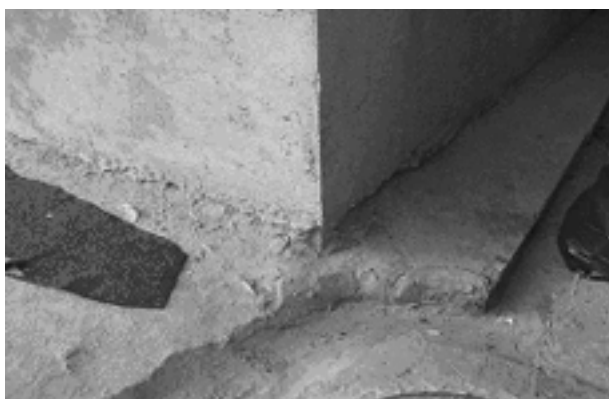
Рис. 2. Сопряжение колонны с фундаментной плитой.
