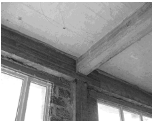
Рис. 3. Узел «ригели – колонна». горизонтальными сетками из 2Ø4ВрI с шагом 600мм.
