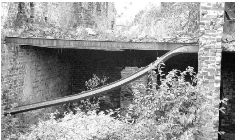
Балка, потерявшая устойчивость в результате изгибного кручения и депланации
