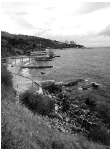
Рис. 15. Береговая полоса в районе Воронцовского дворца. Отсутствие берегозащиты провоцирует возникновение склоновых оползней.
