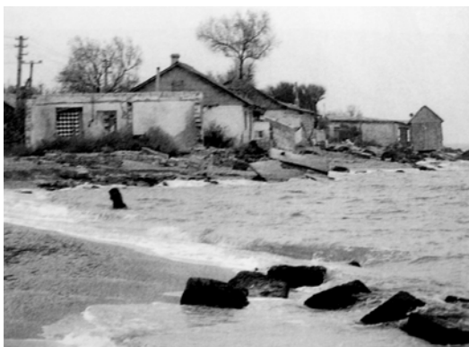
Рис. 7. Аршинцевская коса. Разрушенные дома
