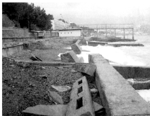
Рис. 10. Разрушенный экстремальными штормами пляж «Солнечный» в г.Ялта.
