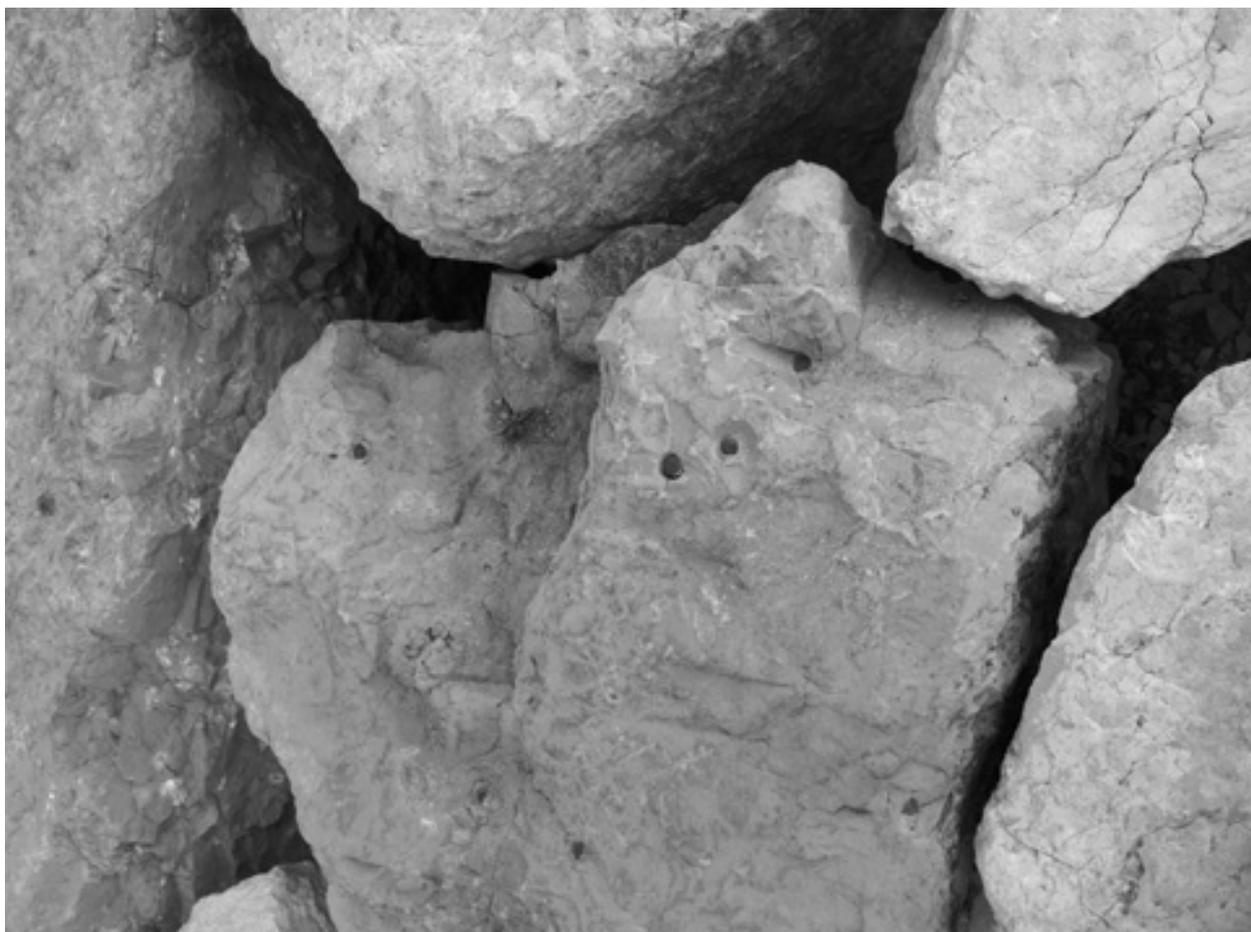
**Рис. 5. Закрепление крупных обломков породы на волноломах с помощью арматуры**
