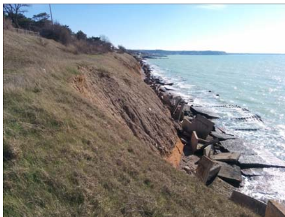
Рис. 7. Состояние берегового клифа на участке не демонтированных ОСВН на 2018 год (вид с севера на юг) [фото авторов]
