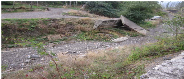
Рис. 1. Река Ворон, разрушенные пешеходный мост, берегоукрепительные сооружения, подмытые берега. Фото автора
