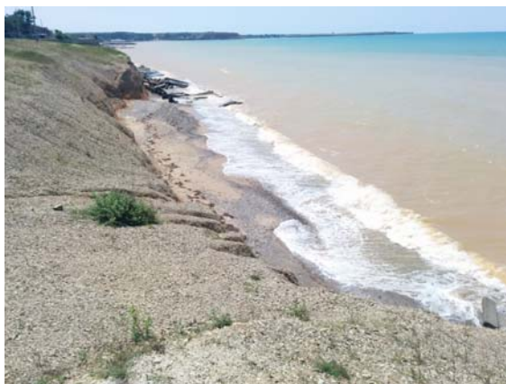
Рис. 3. Состояние образовавшегося пляжа на участке демонтированных ОСВН на 2015 год (вид с севера на юг) [фото авторов]
