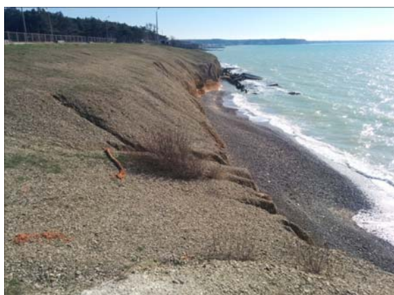
Рис. 5. Состояние образовавшегося пляжа на участке демонтированных ОСВН на 2018 год (вид с севера на юг) [фото авторов]
