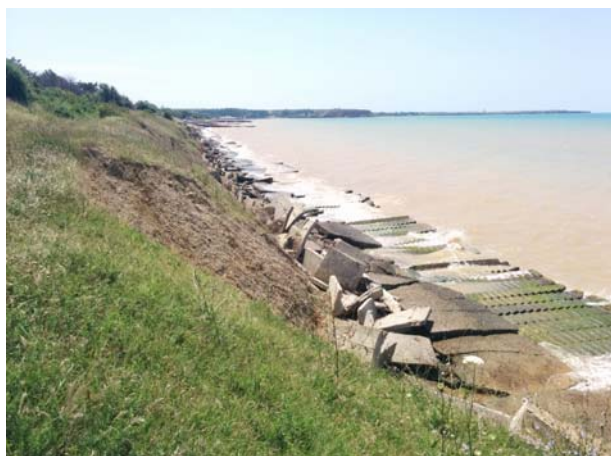
Рис. 6. Состояние берегового клифа на участке не демонтированных ОСВН на 2015 год (вид с севера на юг) [фото авторов]
