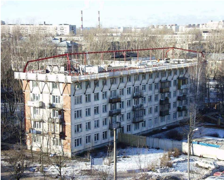
Рис. 9. Принципиальная схема реконструкции здания с надстройкой мансардного этажа и применением комбинированного несущего каркаса мансарды. Устройство несущего опорного каркаса мансарды (второй вариант)
