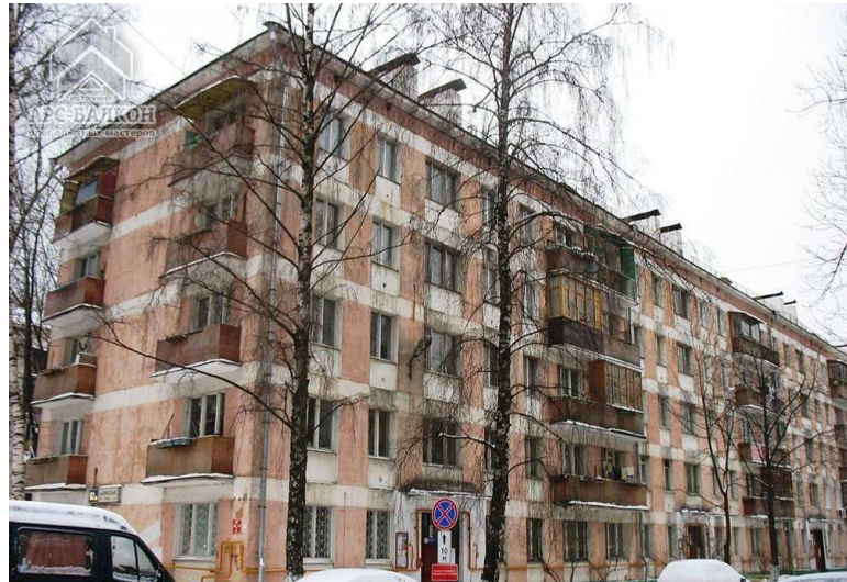
Рис. 4. Фасад дома серии 1-510/5 в г. Симферополь, по адресу ул. Никанорова д. 28А
