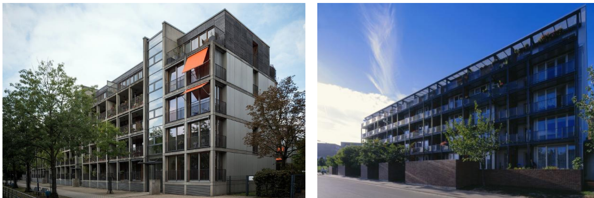
Рис. 1. Германия. Реконструированные крупноблочные жилые здания
