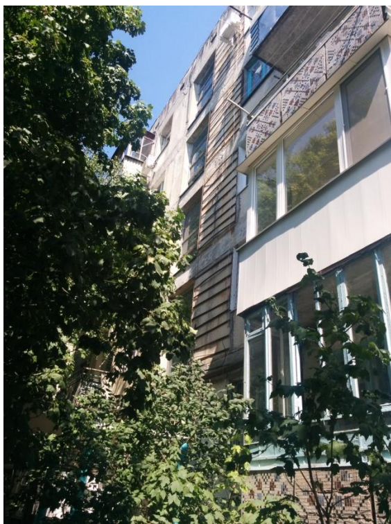
Рис. 4. Фрагмент фасада 5-ти этажного многоквартирного жилого дома с ранее выполненным усилением наружных ограждающих панелей
