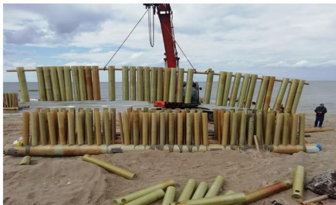
Рис.3. Конструкция комбинированного волногасителя – сборка
