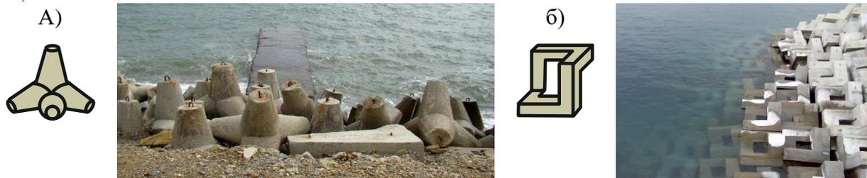
Рис. 1. Конструктивные формы бетонных фасонных блоков:
