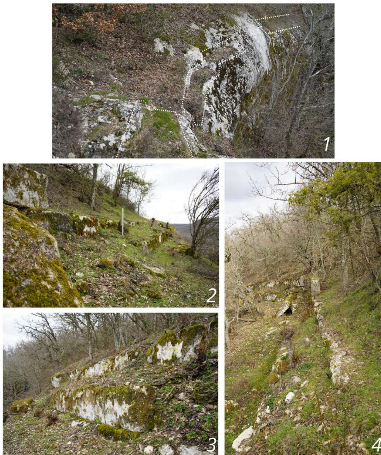
Рис. 107. Оборонительная стена W-W3. 1 – постели северного участка стены; 2 – южный участок стены, вид с севера; 3 – южный участок стены, вид юго-запада, 4 – южный участок стены, вид с юга.
