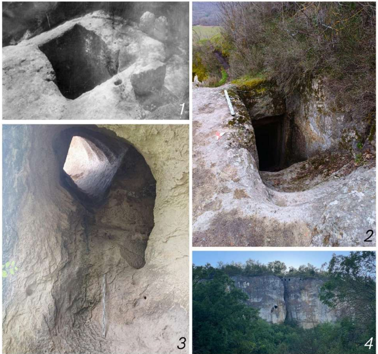
Рис. 75. «Осадный» колодец. 1 – вход в осадный колодец после расчисток 1928-1930 гг. [НА БИКАМЗ. Ф.22. О.1. Д.3. Л. 194; Ломакин 2024, с. 167]; 2 – вход в осадный колодец, современное состояние (фото автора); 3 – пролом на площадке между четвертым и пятым маршем, современное состояние (фото автора); 4 – вид на осадный колодец из балки Текме-Таш (вид с востока, фото автора).
