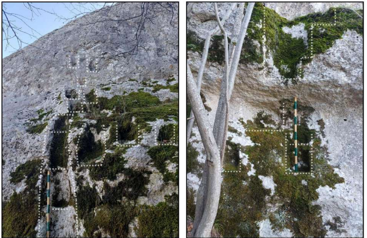
Рис. 82. Ниши и постели куртины N-W1 в стенах скальных мысов. Фото автора.
